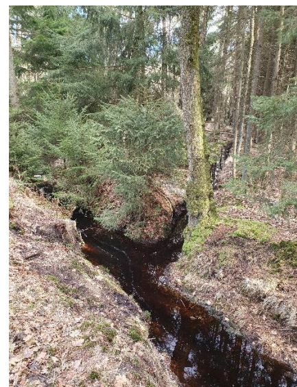
17 Entwässerungsgraben Dorfmarker Moor
