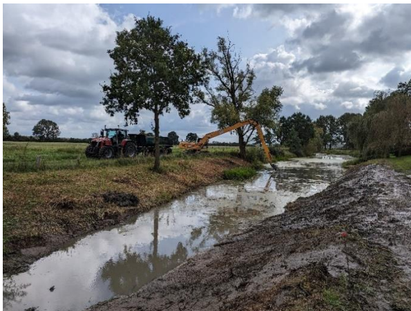
5 Baumaßnahme - Entnahme Sediment
