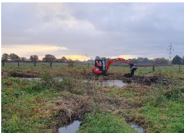
8 Grabenverschluss auf der Fläche in Essel
