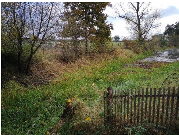
1 Verkräutung vor der Brücke
